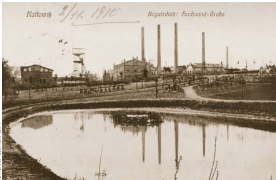
↑ Kopalnia „Ferdynand” (niem. Ferdinandgrube ) w Katowicach (1910). Od 1936 roku nosiła nazwę „Katowice”. Zakończyła swoją działalność w 1999 roku
